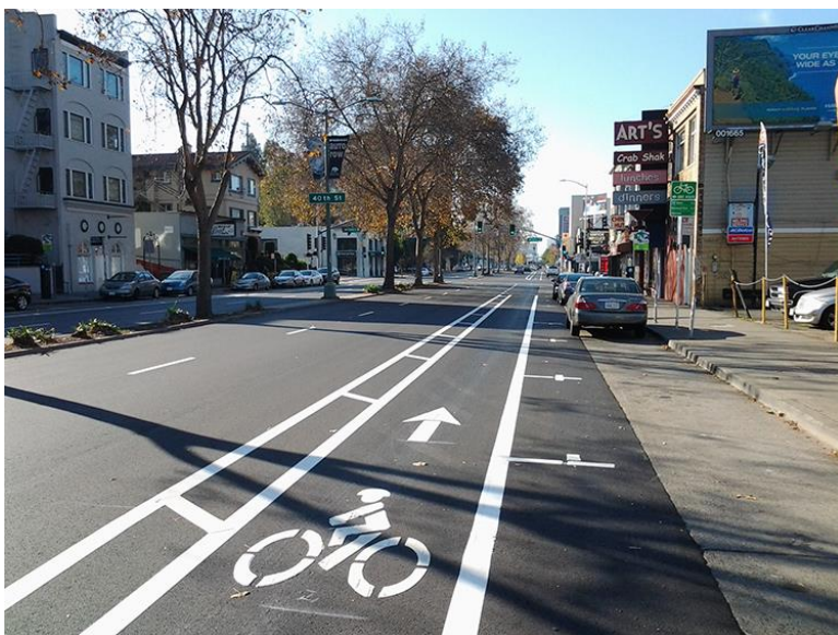
Las nuevas marcas viales en Broadway, de 38th St. a Broadway Ter. incluyen franjas de separación en ambos lados del carril para bicicletas.
